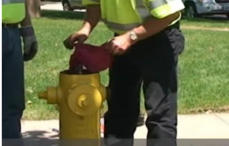
8. Retirer le mécanisme intérieur de la borne d'incendie
