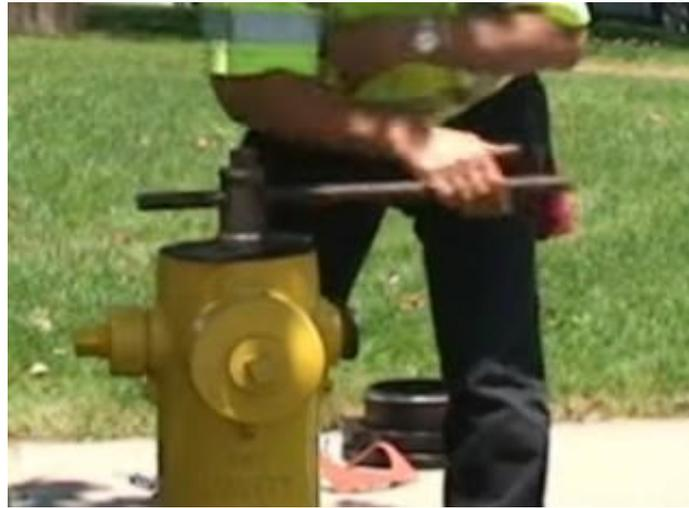
6. Une fois le siège complètement dévissé soulever le mécanisme de quelques pouces et tirant vers le haut la tige en acier.
