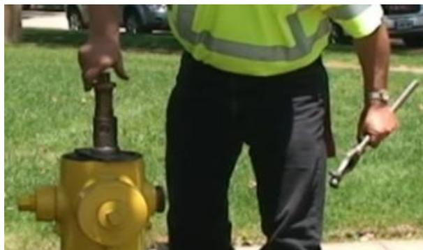
4. Assurez-vous d'ajuster la tige supérieure au niveau de la base de l'orifice situé dans l'écrou en bronze et la clé en acier
