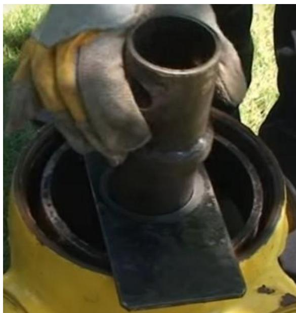
2. Insérer l'écrou en bronze dans la clé en acier
